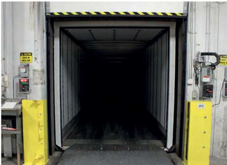
El abrigo de muelle Eclipse NH sella de manera eficaz los espacios de la parte superior, las esquinas y los laterales del remolque, proporcionando un sellado completo, sin filtraciones.
